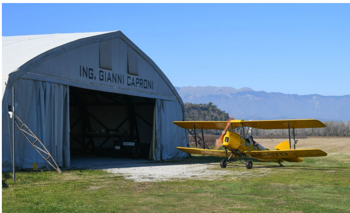
Lo storico Hangar Bessonneau: smontabile e modulare, poteva essere rapidamente spostato per seguire l'avanzamento del fronte durante la Grande Guerra
