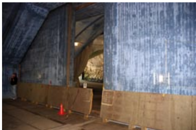
Le impressionanti porte interne in cemento armato, ognuna pesa 60 tonnellate
